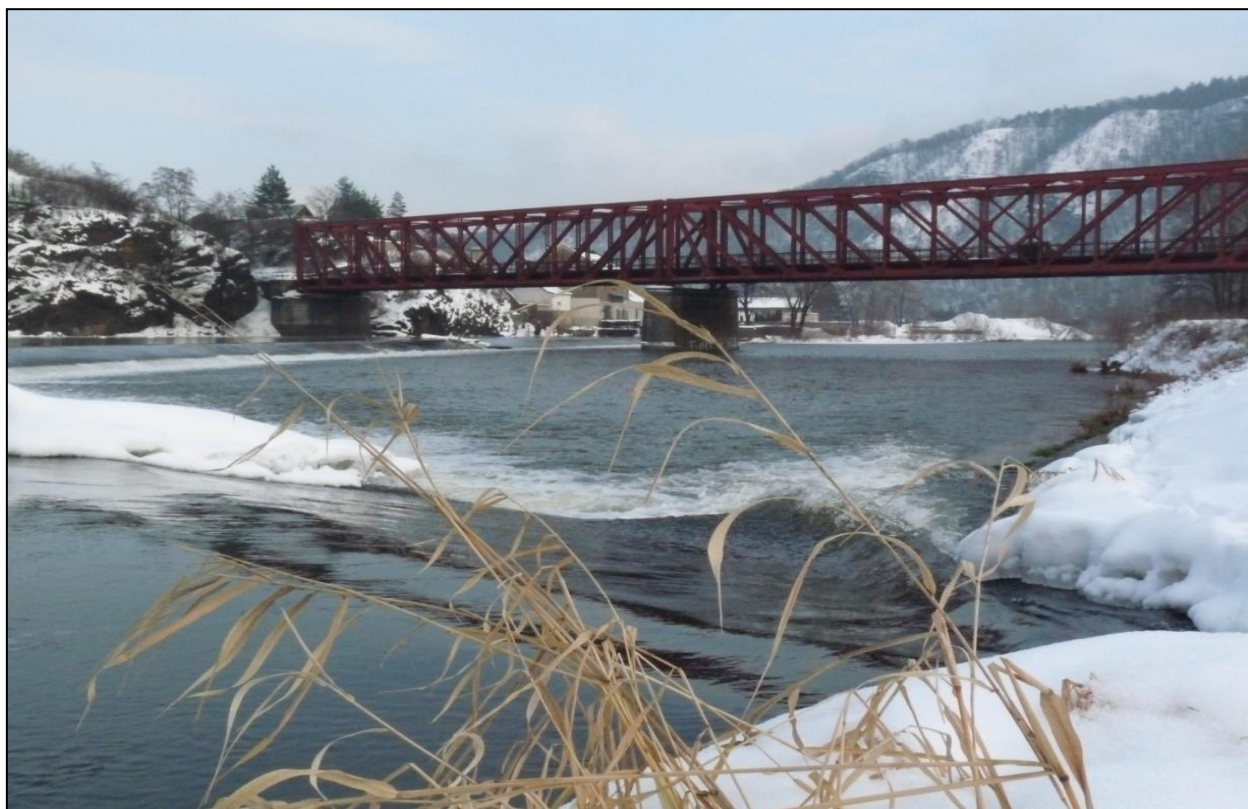
Obr. č. 2 : Všenorský železniční most, pohled z levého břehu.
