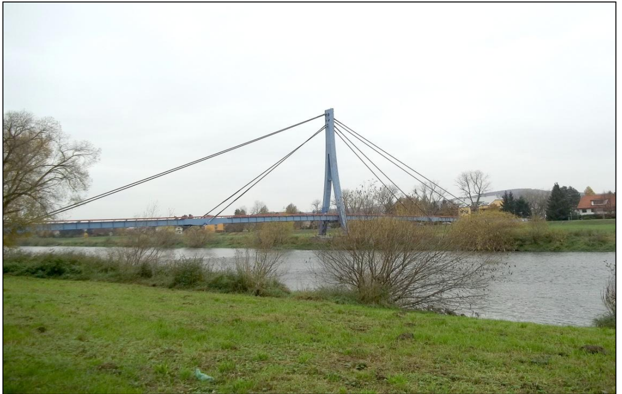
Obr. č. 3: Nová lávka pro pěší v Dobřichovicích.
