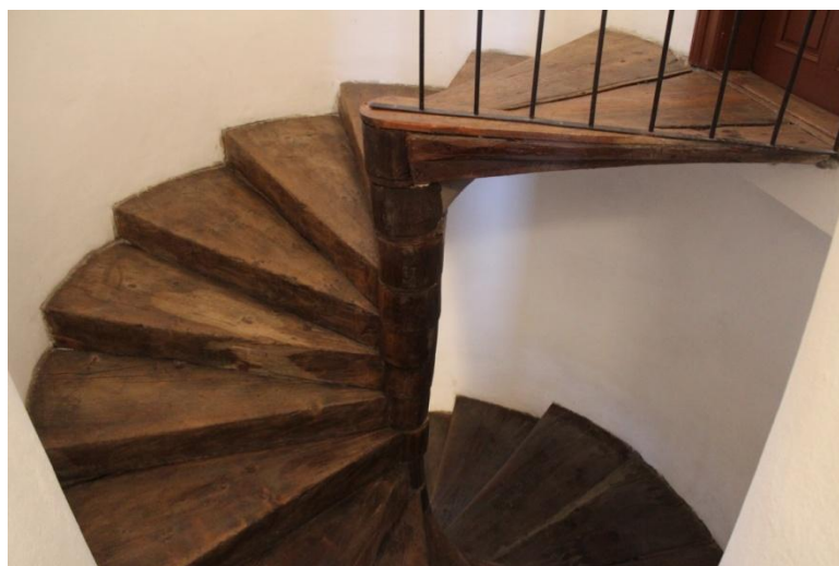
Točité schodiště v kruhové věži
