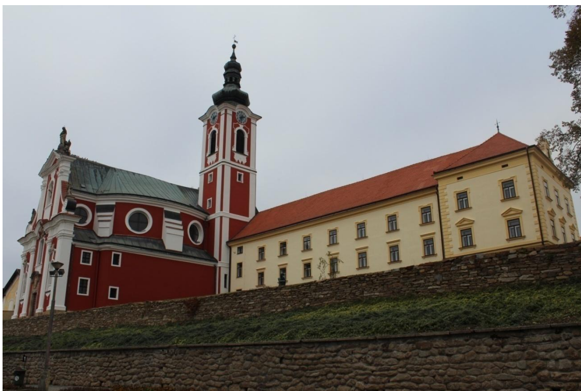
Zámek s kostelem sv. Václava, pohled od náměstí, po rekonstrukci
