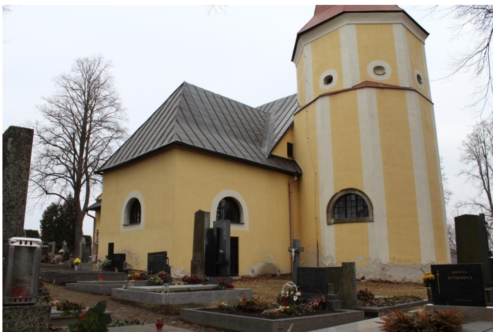
Hřbitovní kostel sv. Barbory, pohled z jižní strany
