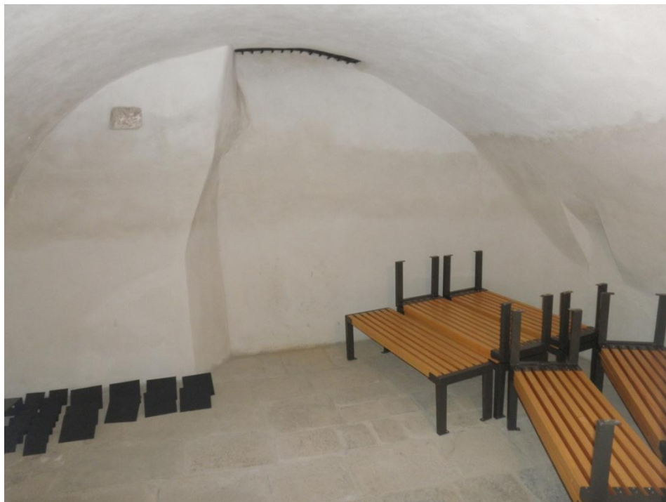
Interiér válcové věže
