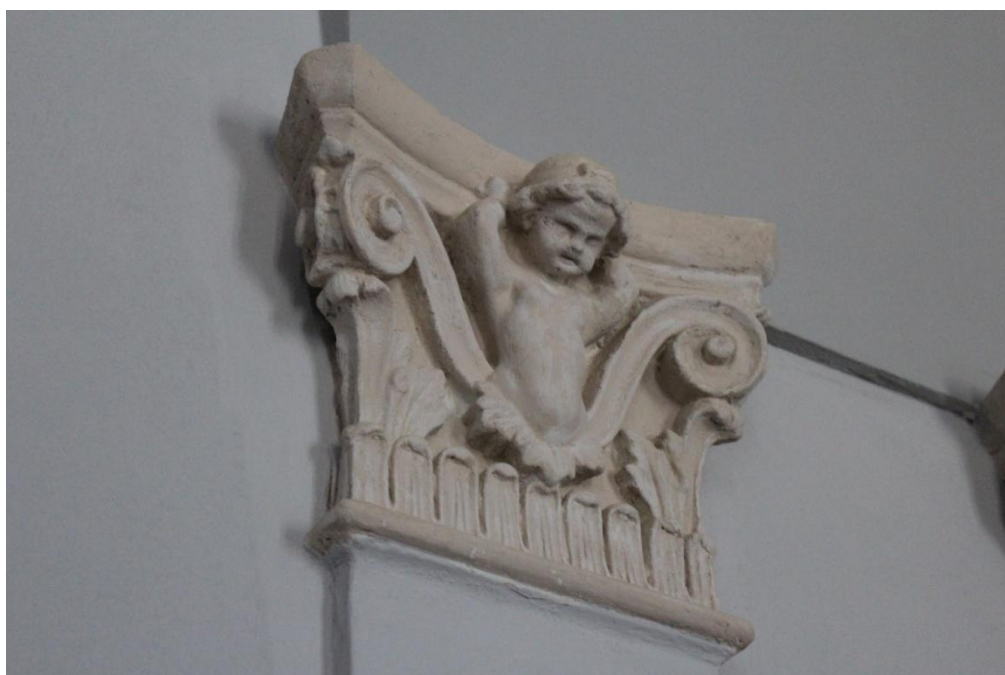
Detail hlavice pilastru v bývalém divadelním sále
