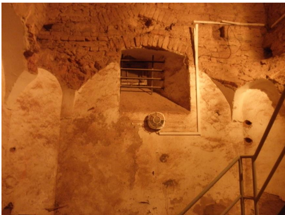
Stržené klenby ve věži, kam bylo vloženo roku 1972 železné schodiště
