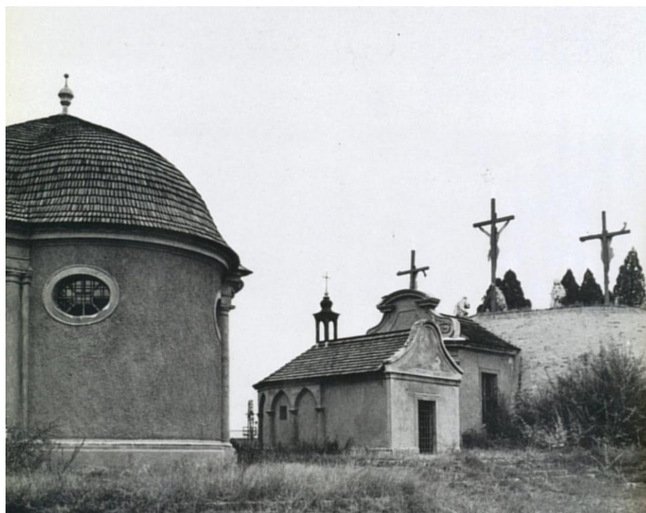
Hřbitovní kaple s křížovou cestou v Györu
