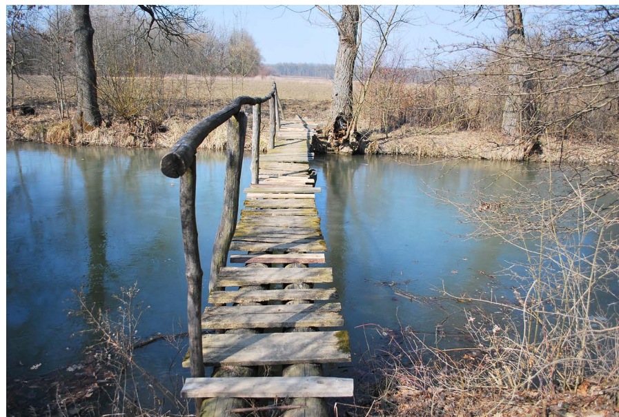
OBR. č. 20 Lávka cez rameno Morávky
