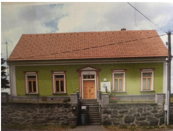
Obrázek 7: školní budova ve Veřechově dnes
