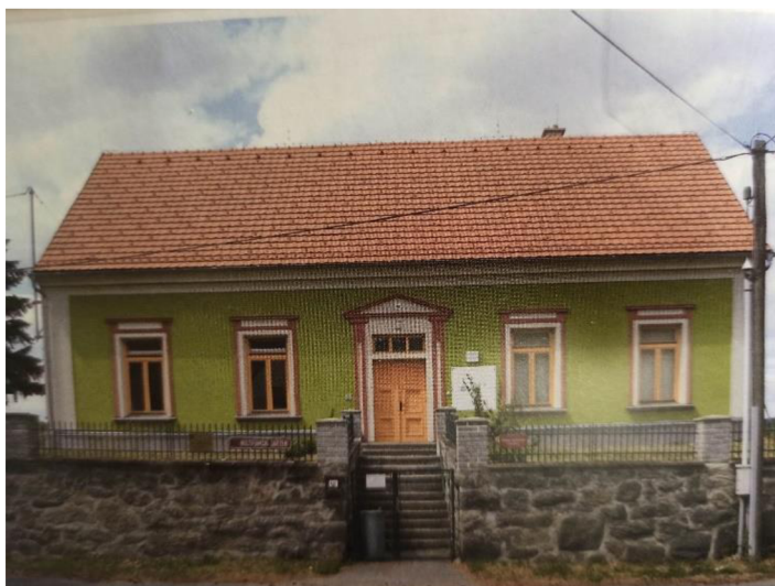
Obrázek 7: školní budova ve Veřechově dnes
