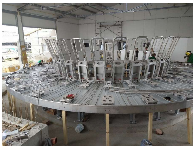
Obrázek 31 - Kruh připravený na betonování (vlastní foto)
