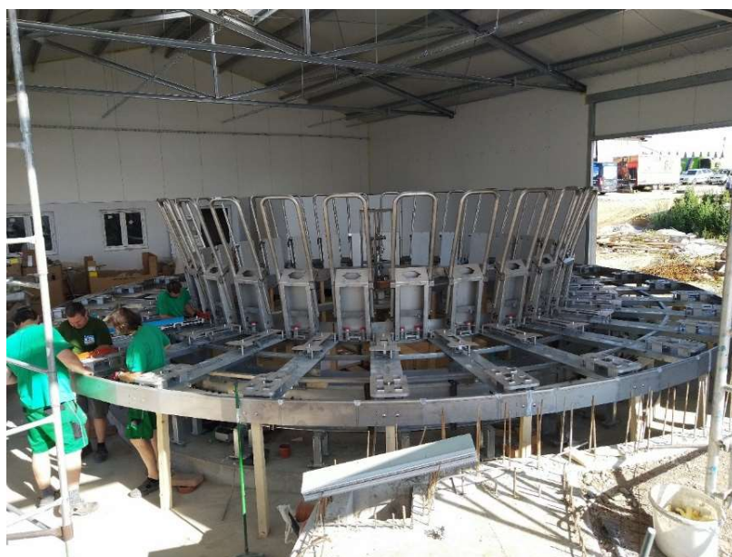
Obrázek 26 - Naváření oblouků a vyrovnávání (vlastní foto)
