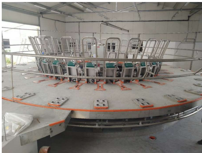
Obrázek 32 - Vybetonovaný kruh (vlastní foto)
