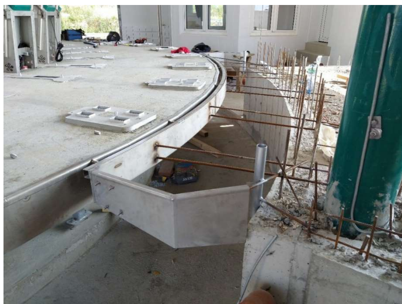
Obrázek 29 - Zabetonovaný sloup jeřábu (vlastní foto)
