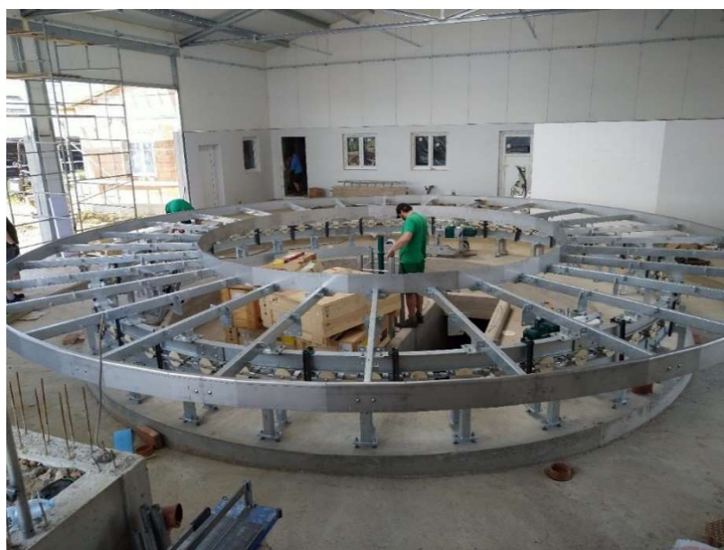
Obrázek 25 - Přimontování paprsků s držáky (vlastní foto)
