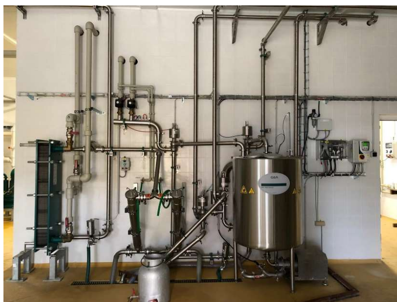
Obrázek 46 - Předchladič, filtry, milk/wash reservoir (vlastní foto)
