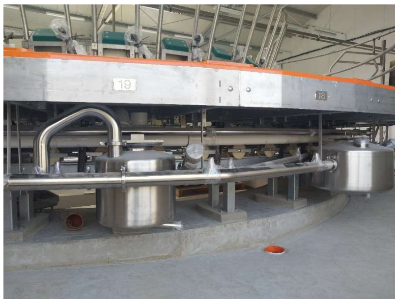
Obrázek 33 - Montování potrubí (vlastní foto)
