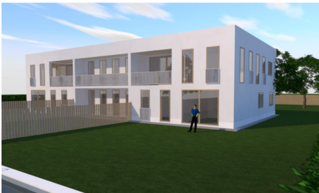
Obrázek 27 Jihovýchodní pohled na stavbu [vlastní]
