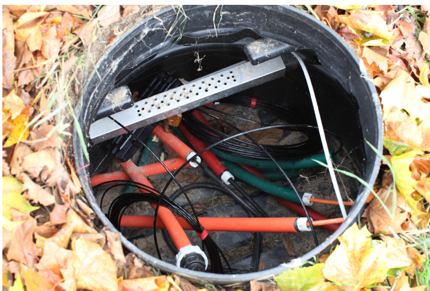
Obr. 1.16: Fotka venkovní šachty.
