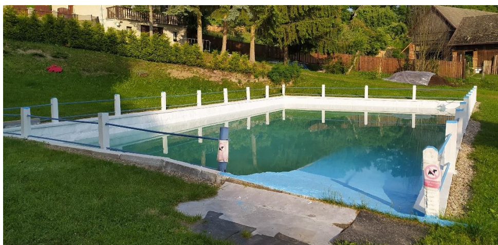
Obrázek 36: Požární nádrž Štěpánovice
