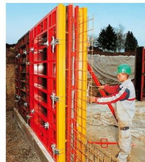
Obr. č. 6 – Provedení pracovní spáry
