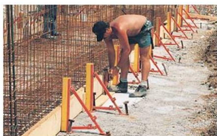
Obr. č. 10 – Opěrné konzoly pro bednění základů
