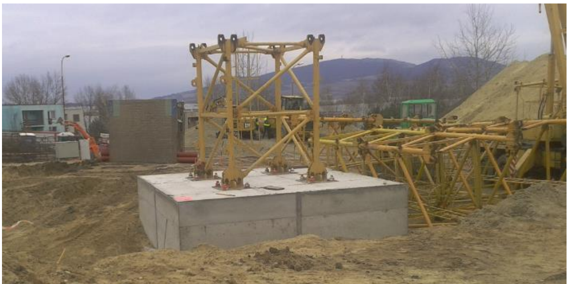
Obr. č. 36 – Základová patka věžového jeřábu – ilustrační foto
