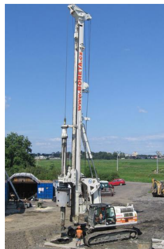
Obr. č. 7 – Vrtná souprava zápor – ilustrační foto
