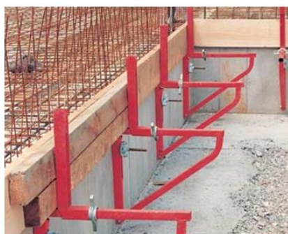
Obr. č. 11 – Bednicí konzoly pro stabilizaci a bezpečnostní lávku
