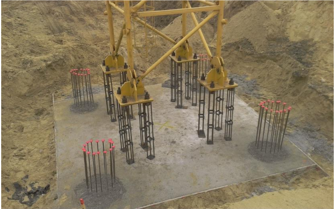
Obr. č. 35 – Základová patka věžového jeřábu – ilustrační foto
