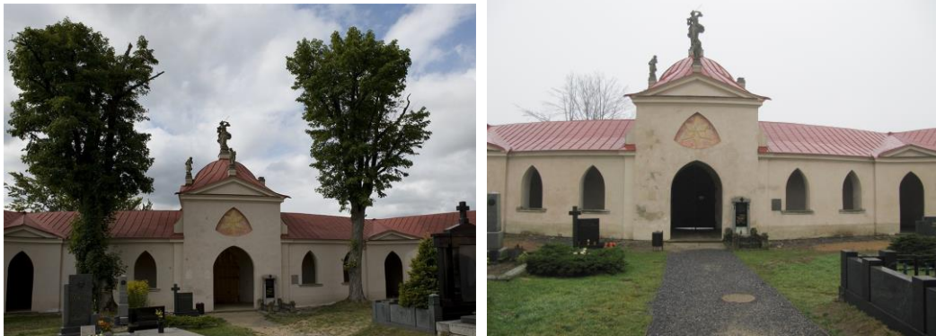
Obr. 23: Pohled na bránu ambitu, Foto: Archiv NPÚ ÚOP v Telči, 2008
