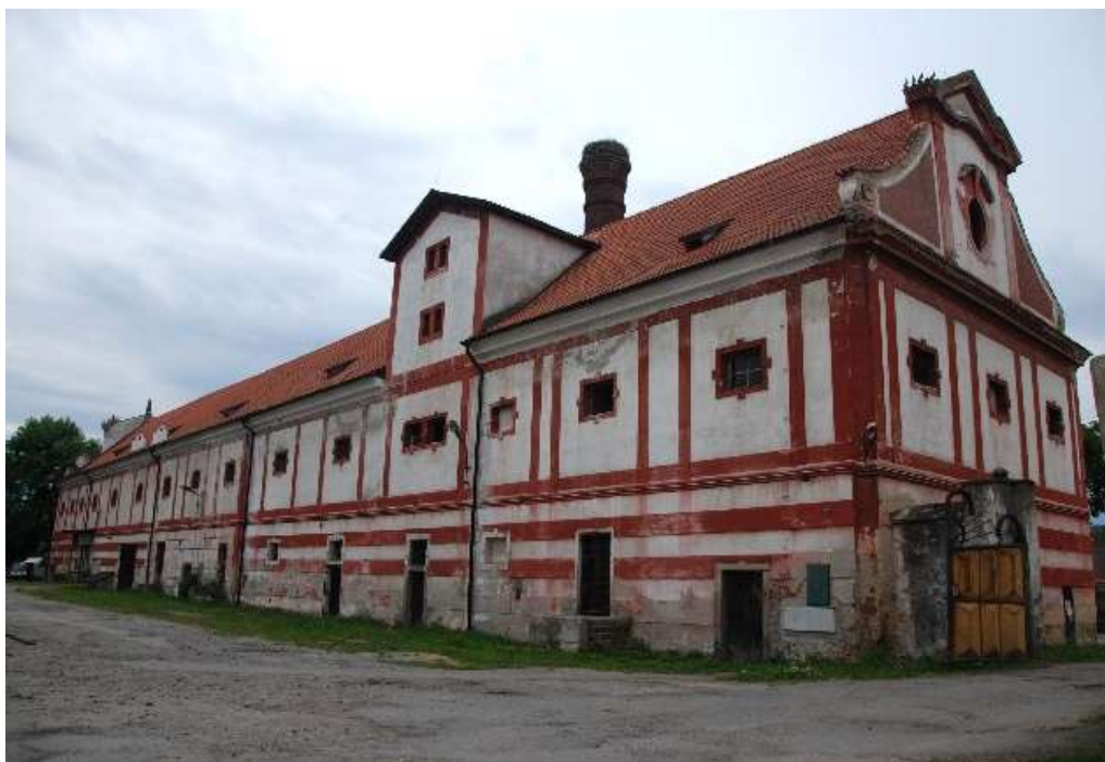
Exteriér před a po rekonstrukci
