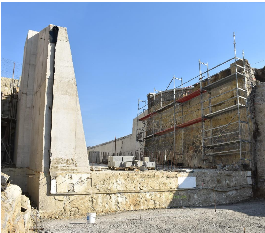
Obrázok 19: Ponechaná pôvodná ľavobrežná stena [20]
