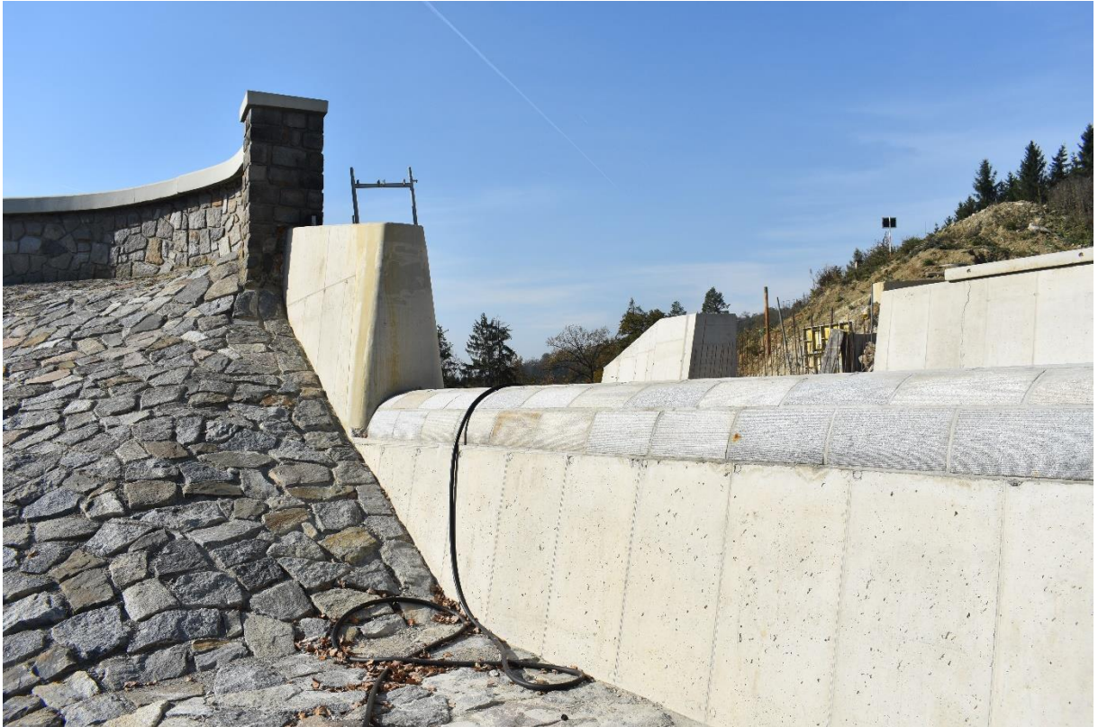
Obrázok 17: Detail napojenia bezpečnostného objektu k hrádzi [20]
