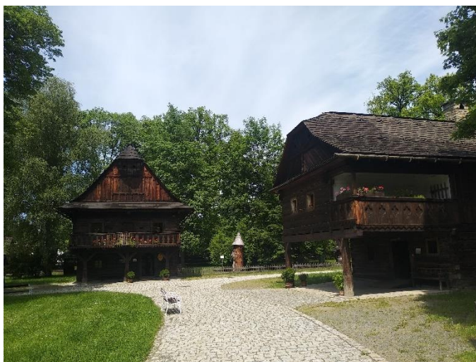
Obrázek 28 Typické venkovské domy 19. století se šindelovou střechou, foto archiv autora
