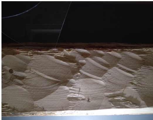
Obrázek 7 Stopy po tesání bradatíci, foto archiv autora
