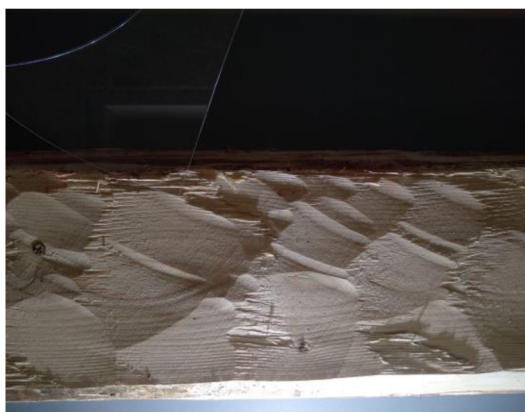
Obrázek 7 Stopy po tesání bradaticí, foto archiv autora
