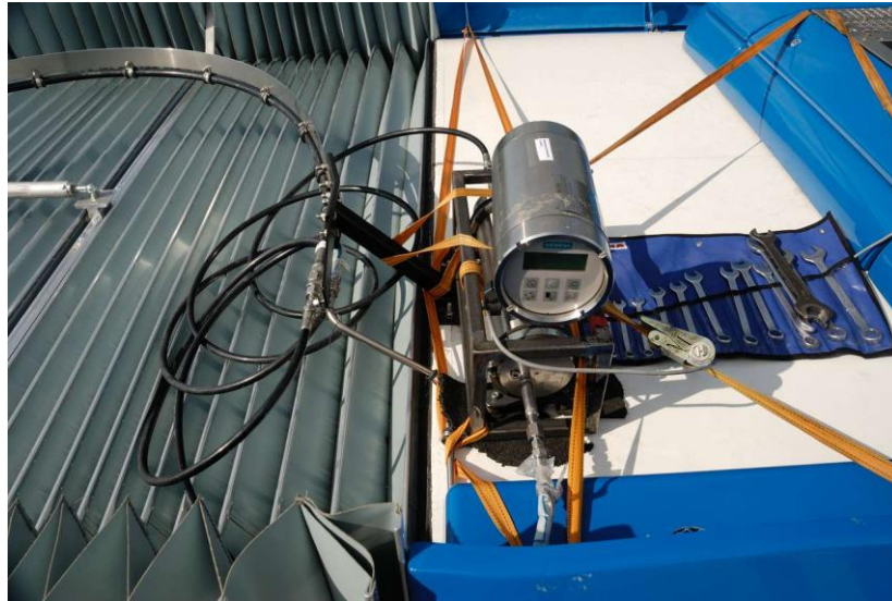
Obr. 10. - Instalace Coriolisova hmotnostního průtokoměru v CNG autobusu
