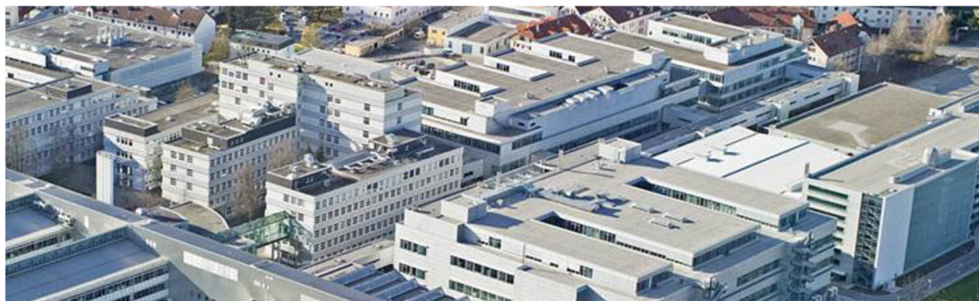
Obrázek 2: Výrobní a administrativní budovy Heidenhain [2]
