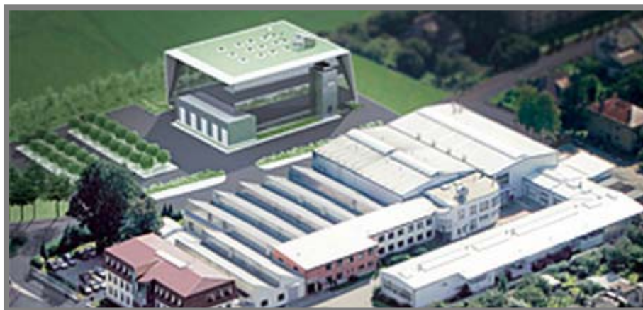
obr. 1: sídlo společnosti SOMA Engineering [1]
