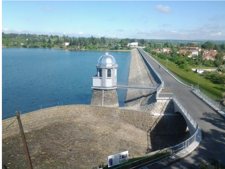
Obrázek 2: Pohled na hráz, věžový objekt a bezpečnostní přeliv (zdroj: vlastní foto).
