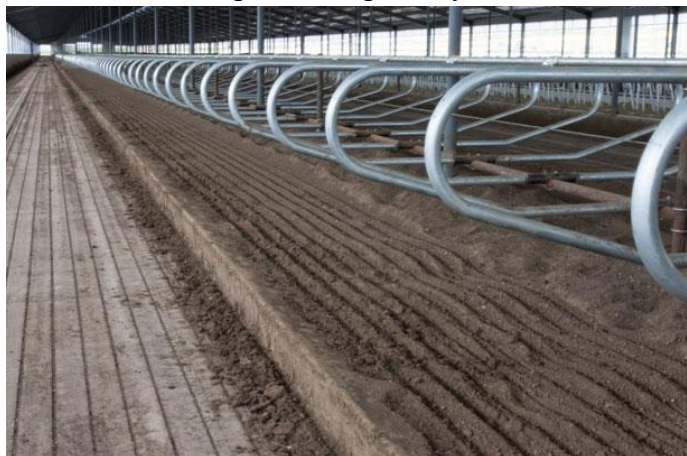
Obr. 8. Betonová podlaha s podélným drážkováním, separát v hlubokém lóži
