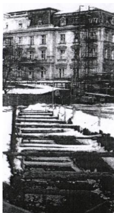
Obrázek 4: Výkop pro stavbu kanalizace u Císařských lázní [10].
