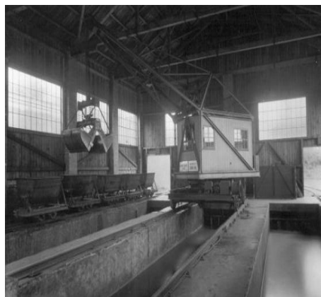
Obrázek 3: Interiér nového lapače písku v bubenečské čistírně [38].
