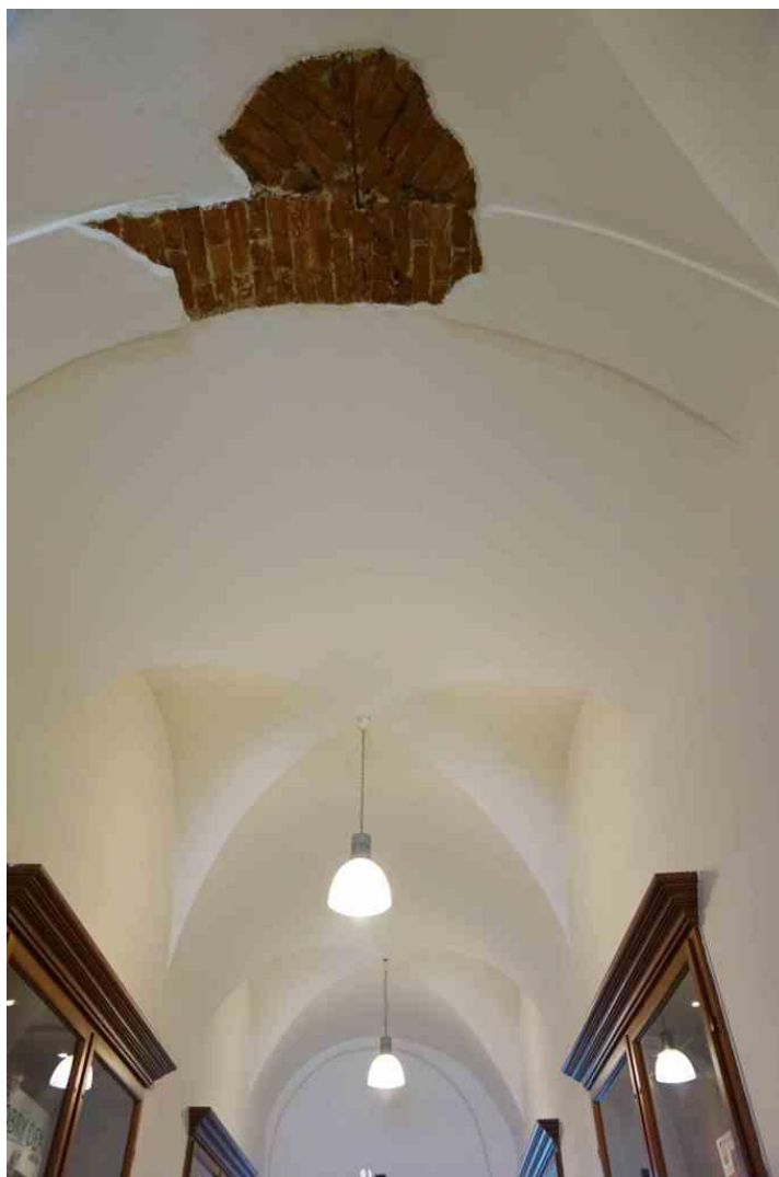
68. Dům „U Slunce“ – valená klenba s lunetovými výsečemi v průjezdu.
