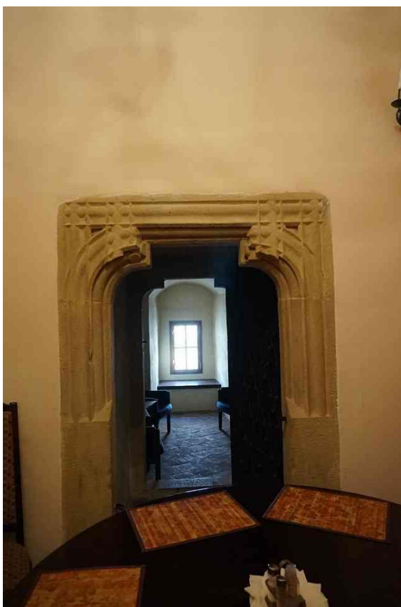
43. Stará radnice – portál č. 2 v 1. poschodí.
