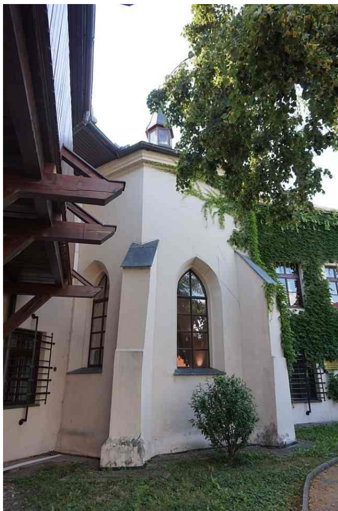
46. Kaple sv. Alžběty – presbytář, pohled z východu.
