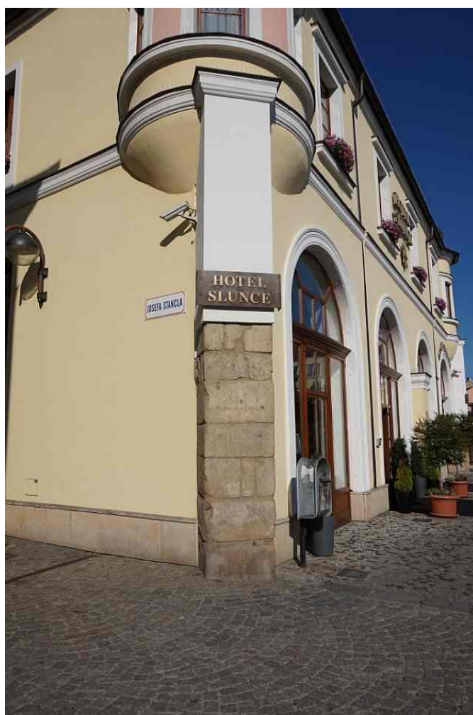
63. Dům „U Slunce“ – nároží a přestavěný arkádové podloubí.
