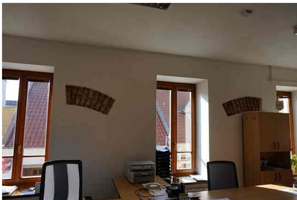
71. Dům „U Slunce“ – fragmenty okenních oblouků, 1. podlaží.
