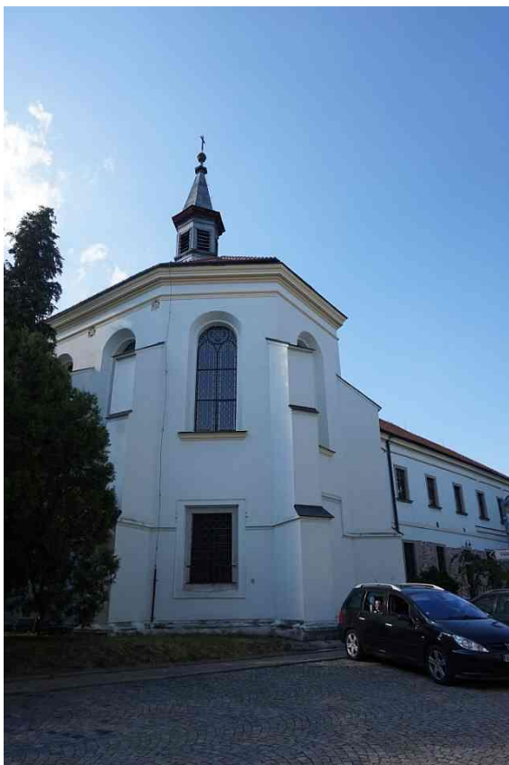
54. Kostel Zvěstování Panny Marie – presbytář, pohled z východu.
