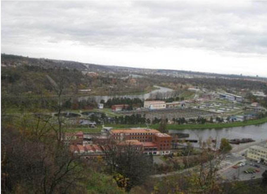
Obrázek č. 4. Čistírna odpadních vod v Podbabě v Praze 6
