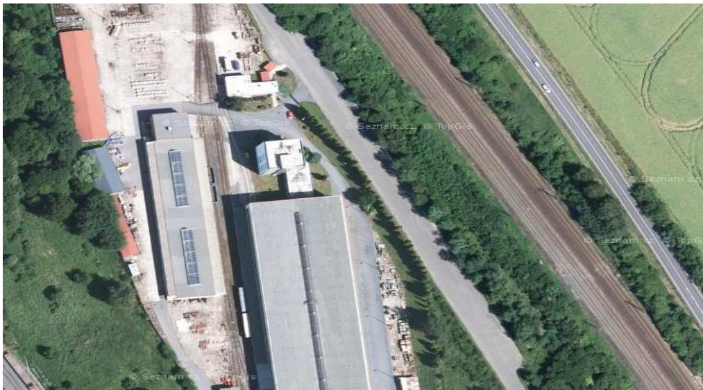
Obr. č. 7.14 – Asfaltová plocha u zásobovacího skladu ČD u Č. Třebové [21]
