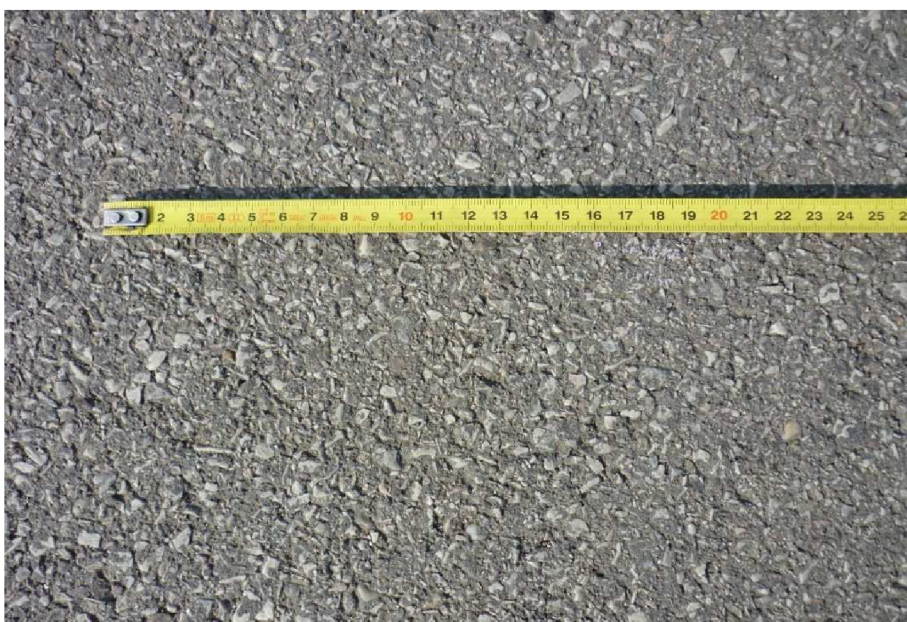
Obr. č. 7.16 – Asfaltový povrch na zpevněné ploše mezi obcemi Kobylice a Králíky [autor]
