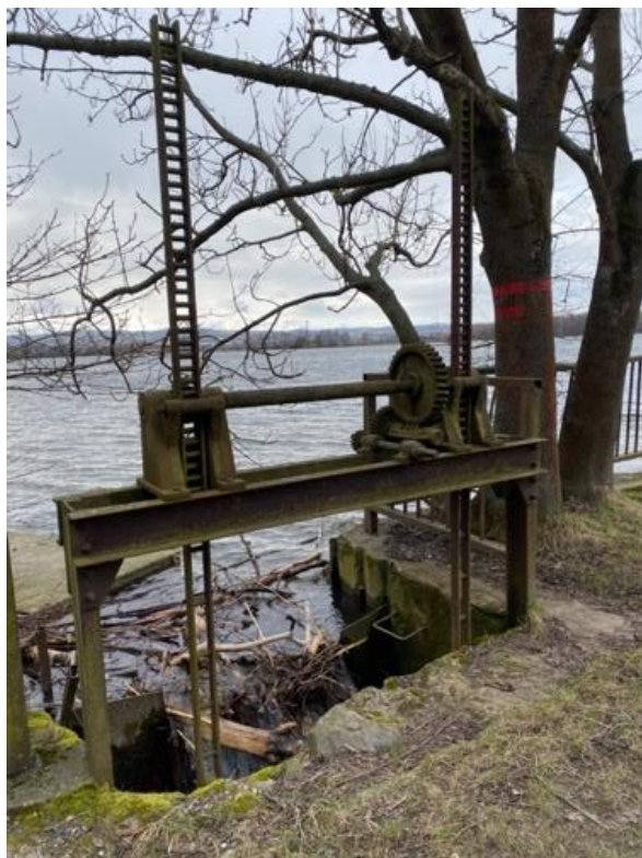
Příloha č. 4 Výpustný objekt na JV okraji jižní štěrkopískovny (archiv autorky)
