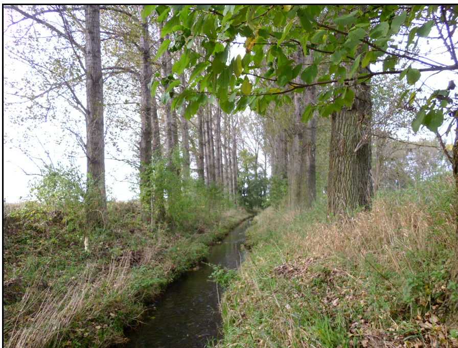
Obr 26.:Fotografie upraveného koryta potoka Chumava za Radouší s počínající renaturací.
