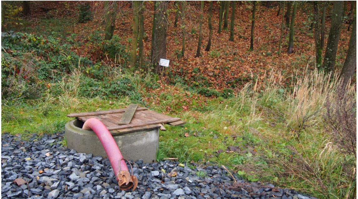
Fotografie 1 Odběrové místo vzorku č. 2, v popředí systém na odvádění metanu z tělesa skládky
