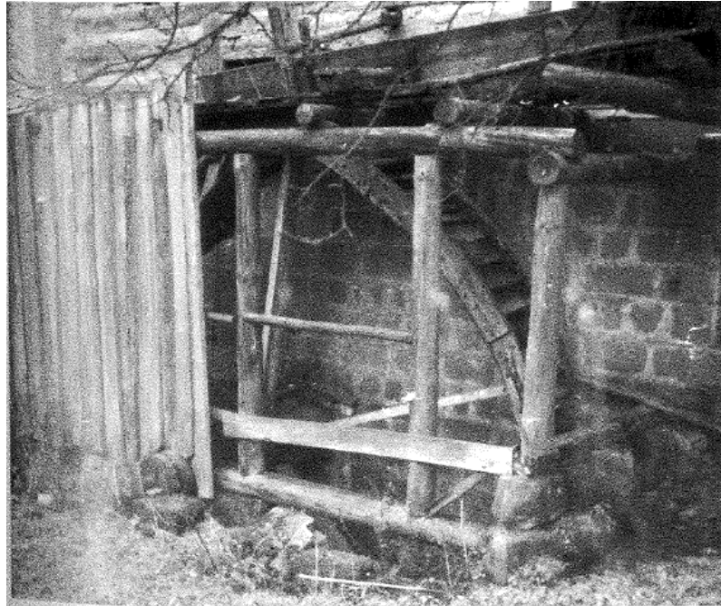
Obr.11. Vodní kolo na horní vodu se zbytky bedněni „lednice“ (zdroj: Kolka, 2014, str. 27)
