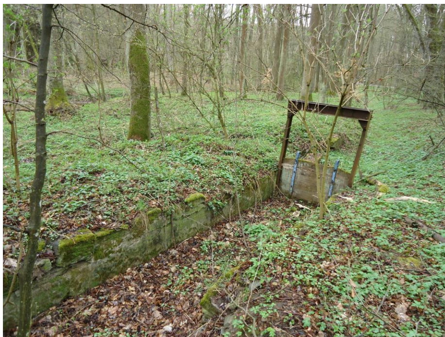
Obr.9. Stavidlo na zaniklém náhonu u Šumice, Náměšť na Hané u koupaliště (autor: Snášelová, duben 2019)
