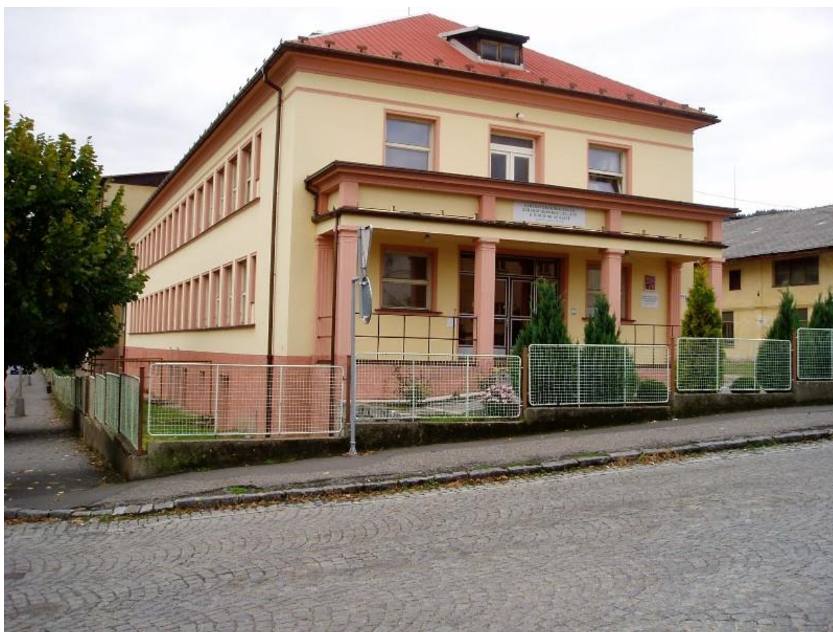
Obrázek 1: Hlavní budova školy. Zdroj: vlastní zpracování.
