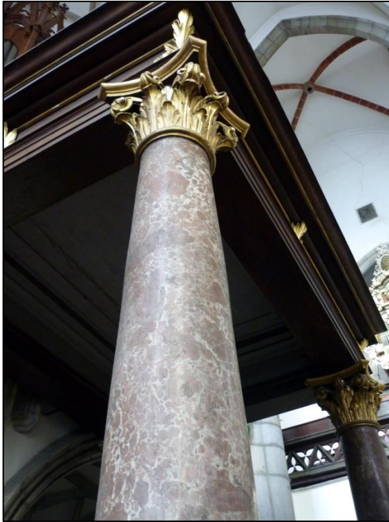
Obr. 22 – Dřevěné korintské hlavice sloupů a barokní kazetový baldachýn nad křtitelnicí, 1683, Foto: autor.
