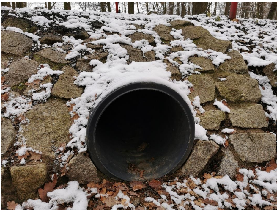
Obrázek 15: Propustek 1 na lesní cestě KO211 Zdroj: vlastní
