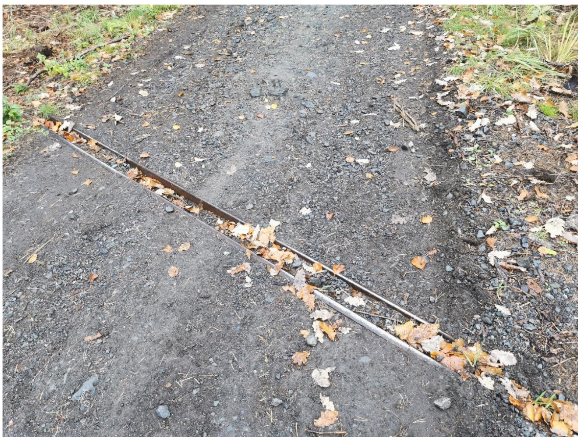
Obrázek 14: Svodnice vody 1 na lesní svážnici KO256 Zdroj: vlastní
