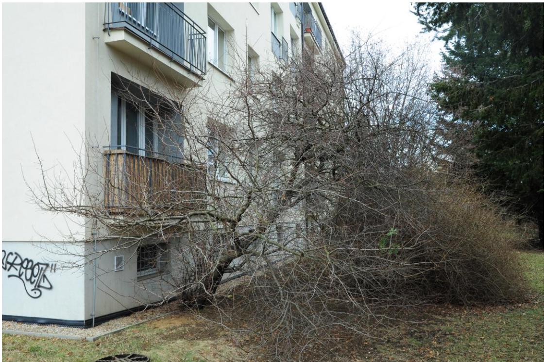
Obrázek č. 7 Zásah do zástavby Zdroj: autor
