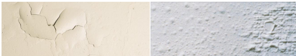
Obr. č. 6: Puchýře na nátěrovém filmu způsobené vzlínající vlhkostí [18]
