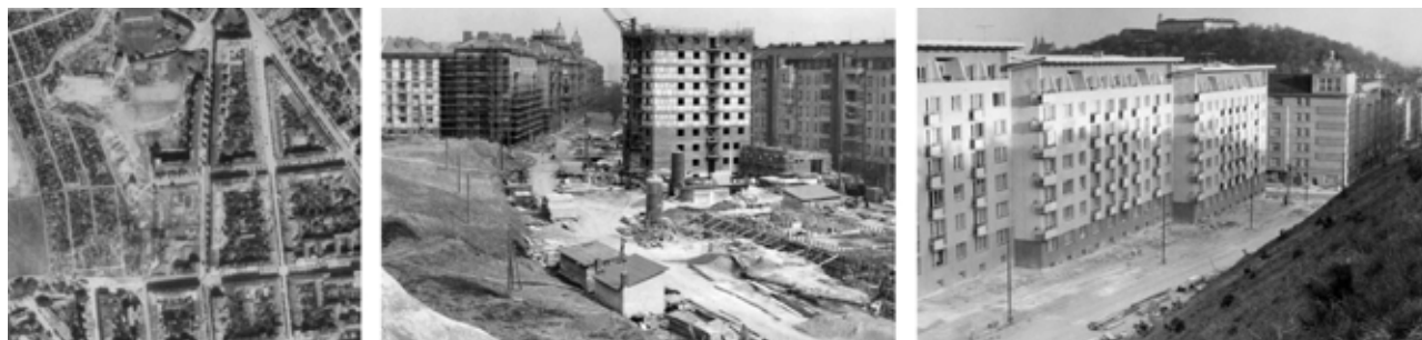
Obr. 32 Sídlíště Úvoz: letecký snímek lokality (1953) 182 před průrazem ulice Úvoz masivem Kraví hory – snímek stavby věžového domu z cihel a z cihelných bloků 183 (duben 1959, řadové domy T03B dosud nestojí) – pohled na dokončenou frontu uskakujících hmot domů T03B (duben 1961) 184
