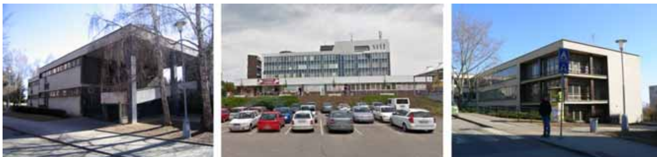
Obr. 99 Sídlíště Bohunice: podoba občanské vybavenosti – první realizované objekty MŠ ještě vycházely z typů vyvinutých pro sídlíště Královo Pole – budova polikliniky dokončená r. 1985 – budova ZŠ Vedlejší 399
