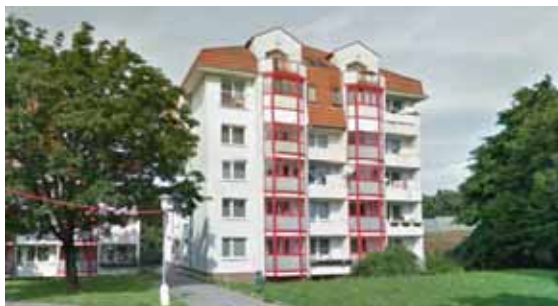
Obr. 63 Sídlíště Žabovřesky: bodové domy zvýšené o střešní nástavbu (ul. Voroněžská a ul. G. Preisové) – vpravo zdařilý příklad řešení zateplení výškového domu (ul. Voroněžská) 292
