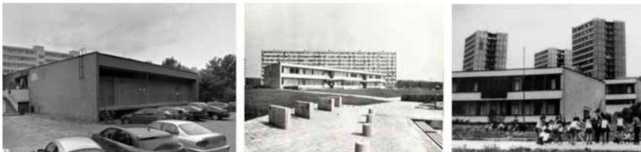
Obr. 56 Sídlíště Lesná: objekt technické vybavenosti, tzv. „výměňík“ (Brožíkova, dnešní stav) – objekt MŠ a deskový dům (Brechtova, zač. 70 let) – objekt ZŠ (Nejedlého, foto zač. 70 let) 277
