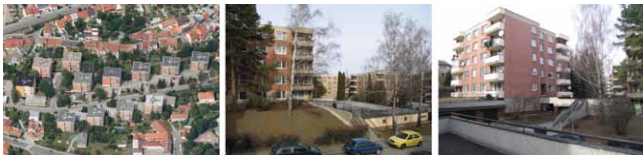
Obr. 77 Sídlíště Řečkovice: obytný soubor Vážného; jedná se o poměrně zdařilou realizaci urbanisticky kompaktnějšího celku příjemného měřítka (zděné pětipodlažní bodové domy vycházející typově ze „Zounkových kostek“, původně určených pro sídlíště Lesná; na svou dobu poměrně kvalitní projekt a provedení okolí domů (skupinové garáže v podnožích domů, rampy a schodiště ke vstupům) 329
