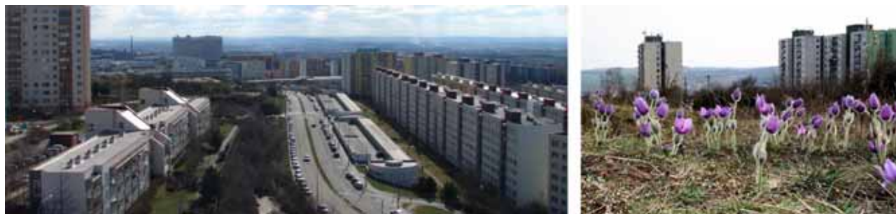
Obr. 121 Sídlíště Kamenný vrch, současné snímky veřejných prostranství sídliště 459 : „páteří“ sídliště je dopravní koridor ulice Petra Křivky, v 90. letech obestavěný objekty patrových garáží, které sice pomohly naprostému nedostatku parkovacích míst v husté zástavbě, ale nepomohly polyfunkčnosti dopravního koridoru – jedním ze symbolů sídliště Kamenný vrch je jarní louka s bohatým výskytem kvetoucích konikleců – přírodní rezervace Kamenný vrch (vyhlášená r. 1978 jako přírodní památka)
