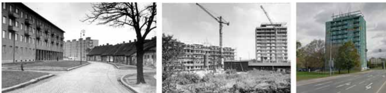
Obř. 34 Sídlíště Na Nábřeží: původní zástavba v místech dnešní haly Rondo v roce 1965 189 – výstavba experimentálních domů dne 30. 9. 1960 190 – současný stav
