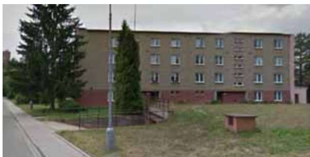
Obr. 94 Sídlíště Bystrc: řadková zástavba zděnými bytovými domy z počátku 60. let, ještě před výstavbou sídliště – ul. Filipova, stávající stav (řadové čtyřpodlažní domy s nástavbou a zateplěným pláštěm) 383
