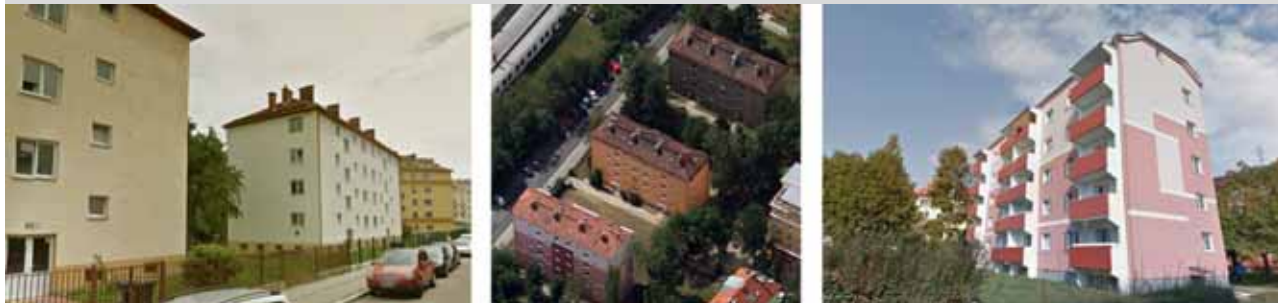
Obr. 16 Bytovky Renneská – příklady přístupů k „regeneraci“ domů: vlevo světlé odstíny fasád respektují původní podobu domů (ul. Havlenova) – vpravo příklad nepochopení architektury domu a donekonečna opakované (ekonomicky výhodné) řešení představených betonových loggií propůjčují cihelnému domu těžkopádný výraz „tuctového paneláku“ (ul. Dvorského) 120
