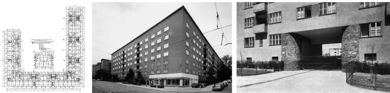
Obr. 8 Merhautova, bytový dům družstva Freundschaft, dobové snímky 70 : půdorys typického podlaží (9 schodišťových sekcí se vstupy ze dvora a jeden společný vjezd do dvora – pohled z ulice Merhautovy – společný vstup – průchod do dvora
