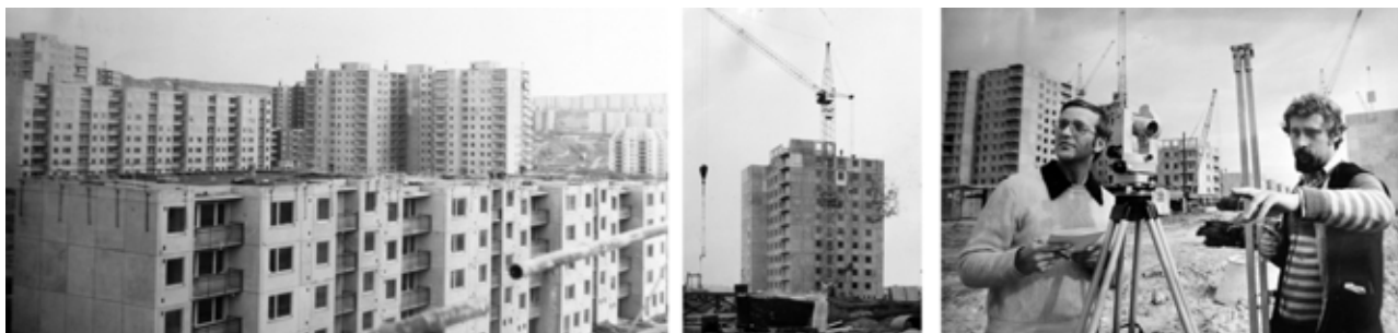
Obr. 113 Sídlíště Vinohrady: snímky z výstavby sídliště 437
