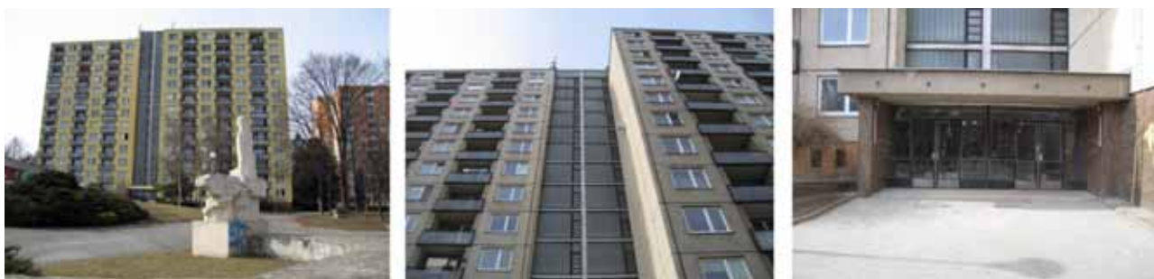
Obr. 75 Sídliště Řečkovice: výškové domy na Horáckém náměstí 326 ; obrovská hmota pěti domů je dominantou volného prostranství před nimi (park, areál ZŠ a sportoviště); výškový dům je příkladem tlaku doby na zvyšování hustoty zastavění a počtu postavených bytů v sídlištích, a zároveň snižování kvality provedení a kvality architektonického detailu („vstup dělá dům“ 327 ) – odbyté proporční i materiálové řešení vstupu pro 140 „partají“; na prvním snímku plastika J. Marka: Vysočina, součást původní výtvarné výzdoby sídliště
