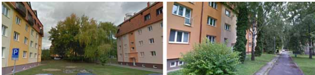
Obr. 18 Bytovky Tilhonova – nižší zástavba, zelené plochy mezi domy a úzké obslužné komunikace přispívají k intimnější atmosféře „vnitrobloku“ obytného souboru (foto 2011) 125
