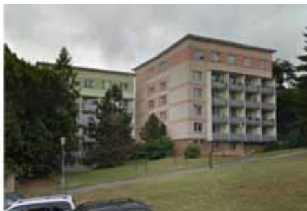
Obr. 63 Sídlíště Žabovřesky: bodové domy zvýšené o střešní nástavbu (ul. Voroněžská a ul. G. Preisové) – vpravo zdařilý příklad řešení zateplení výškového domu (ul. Voroněžská) 292
