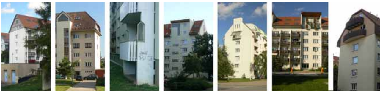
Obr. 40 Sídlíště Juliánov, mnohdy až dětsky naivní podoba střešních nástaveb na původně pětipodlažních panelových domech B60 provedené v 90. letech minulého století 238
