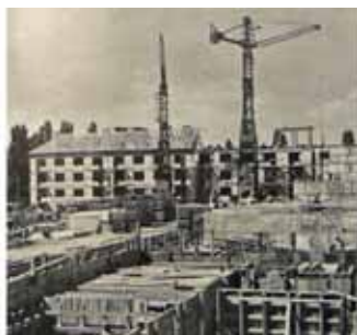
Obr. 26 Bráfova: dobový snímek uliční fasády 155 – výstavba souboru z prefabrikátů – z cihelných bloků 156 – „dvorní“ fasády a objekt MŠ 157 (autor Z. Kříž)
