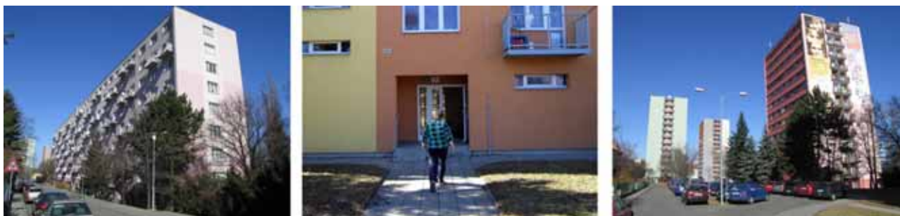
Obr. 52 Sídlíště Staré Brno – jih, současné snímky bytových domů: živé odstíny barev a velkoplošné reklamní bannery na fasádách 264
