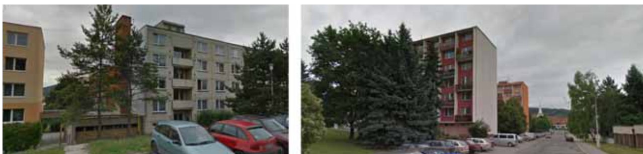
Obr. 82 Sídlíště Komín – pětipodlažní deskové domy orientované okny J-S (ul. Čoupkových); řada šesti sekcí předělené objektem plynové kotelny a redukční stanice s průchodem – motiv použitý již v sídlišti Řečkovice - deskové domy o dvou sekcích, orientované okny V-Z, v průhledu ulice kostel Sv. Vavřínce
