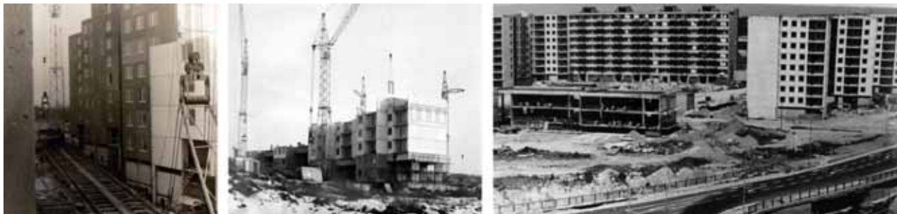
Obr. 98 Sídlíště Bohunice: fotografie z výstavby sídliště 398
