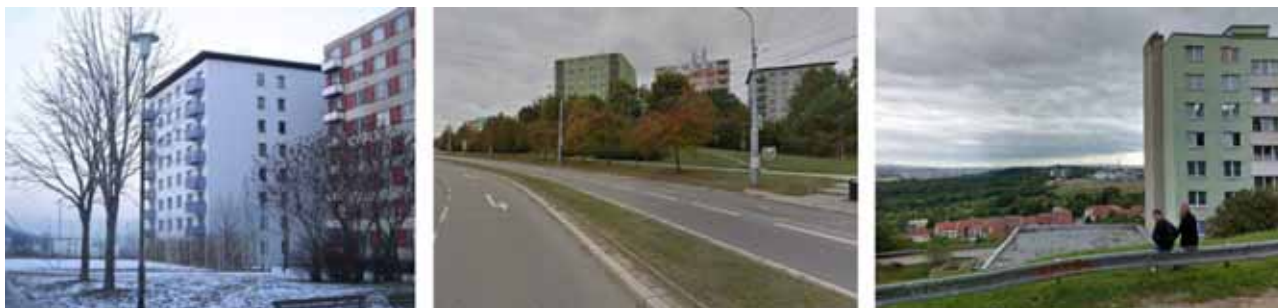
Obr. 109 Sídlíště Nový Lískovec: výjimečný příklad dobře zvládnuté regenerace panelového domu (vlevo objekt po regeneraci, vpravo před) – ul. Petra Křivky – svými rozměrovými parametry je ulice dopravním koridorem, městotvorným zásahem je alej jeřábů – výhled k východu zpoza „duhového“ domu
