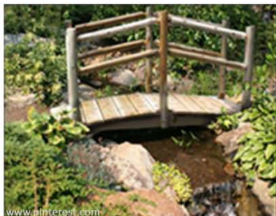
Příklad dřevěného mostu přes potok
