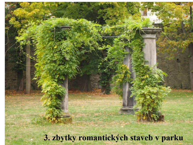
Obr. 22: Pozůstatek romantických staveb v parku
