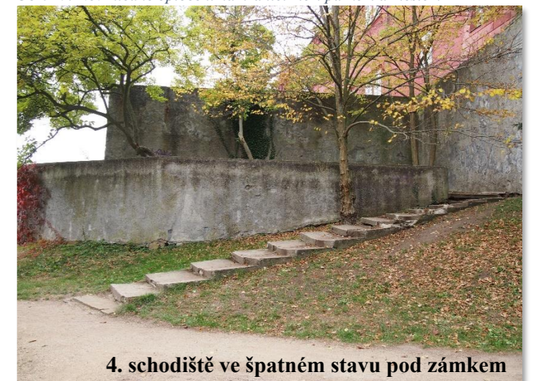
Obr. 29: Staré přístupové schodiště k jižní terase pod zámek
