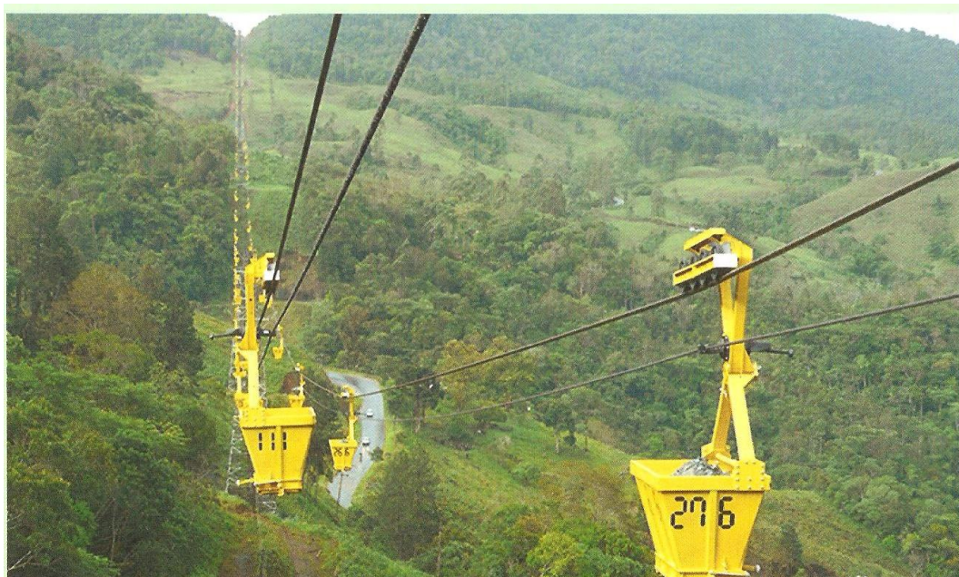
Příloha č. 2 Vozíky lanové dráhy (DIAMO, 2017)
