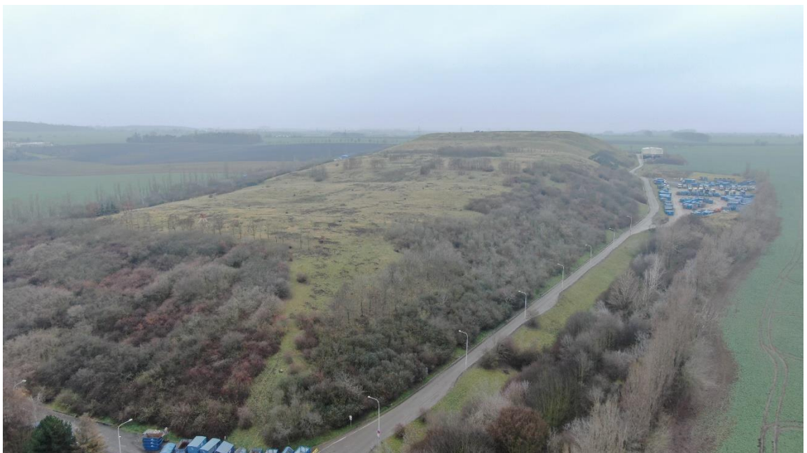
Příloha 2: Pohled na skládku z východní strany (foceno autorkou pomocí dronu)
