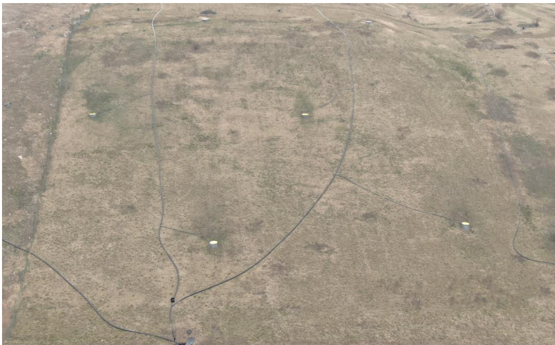
Obrázek 11: Potrubí horního odtahu PE-HD D90, 160 a jímací studny bioplynu (foceno autorkou pomocí dronu)
