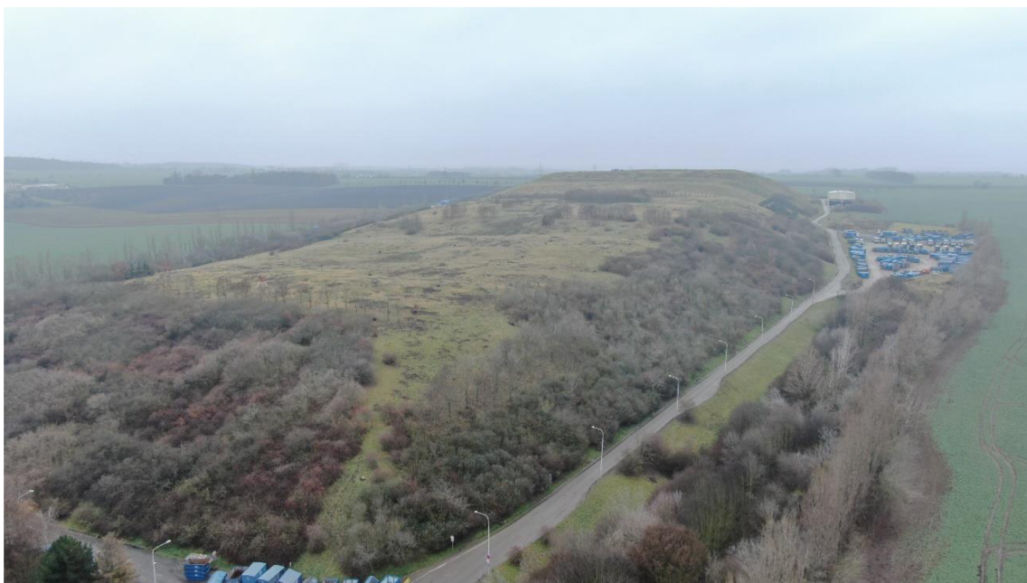
Příloha 2: Pohled na skládku z východní strany (foceno autorkou pomocí dronu)
