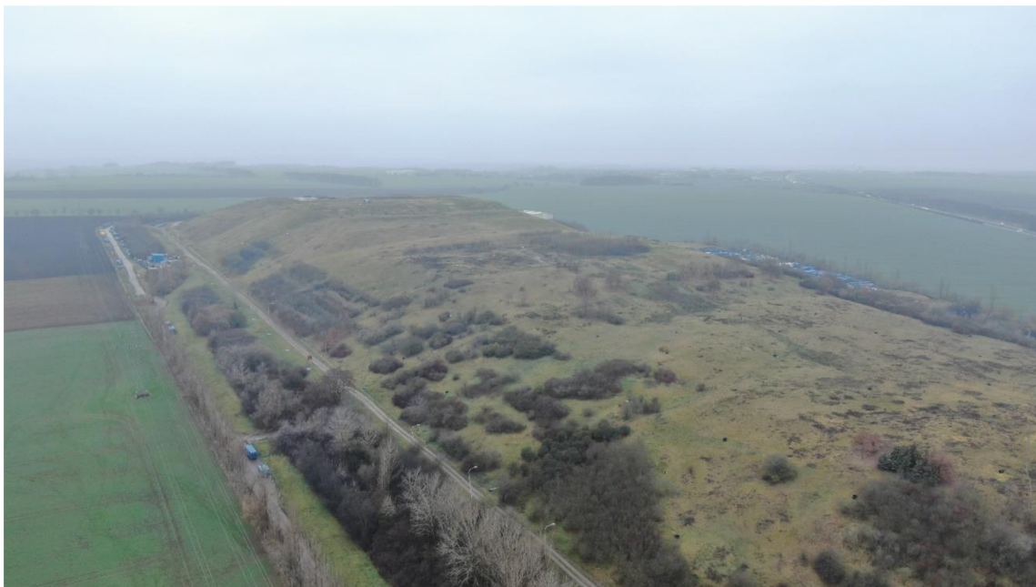
Příloha 5: Pohled na skládku z východní strany (foceno autorkou pomocí dronu)
