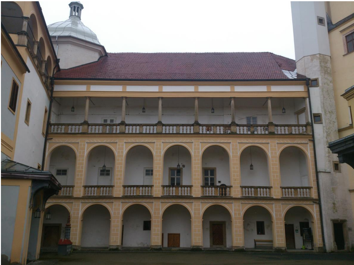
45. Arkádové ochozy východního křídla zámku, pohled ze západu.
