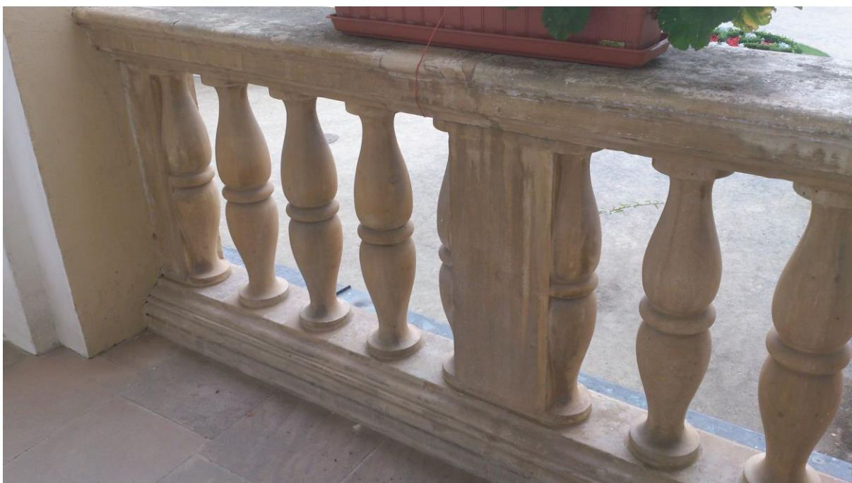
48. Detail balustrád v prvním arkádovém patře.
