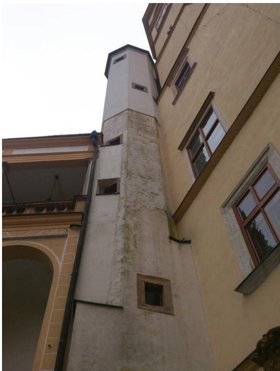
31. Věž s vřetenovým schodiště.
