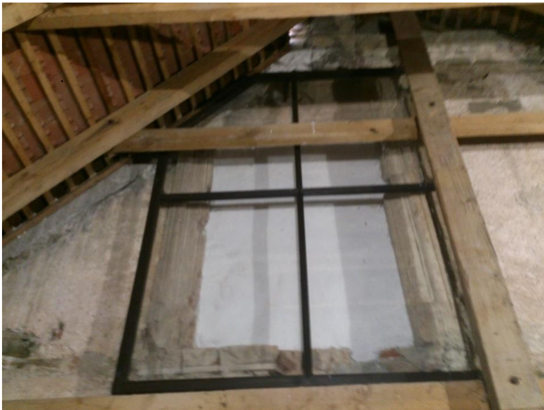
12. Zazděné okno, pohled z podkroví východního křídla zámku.
