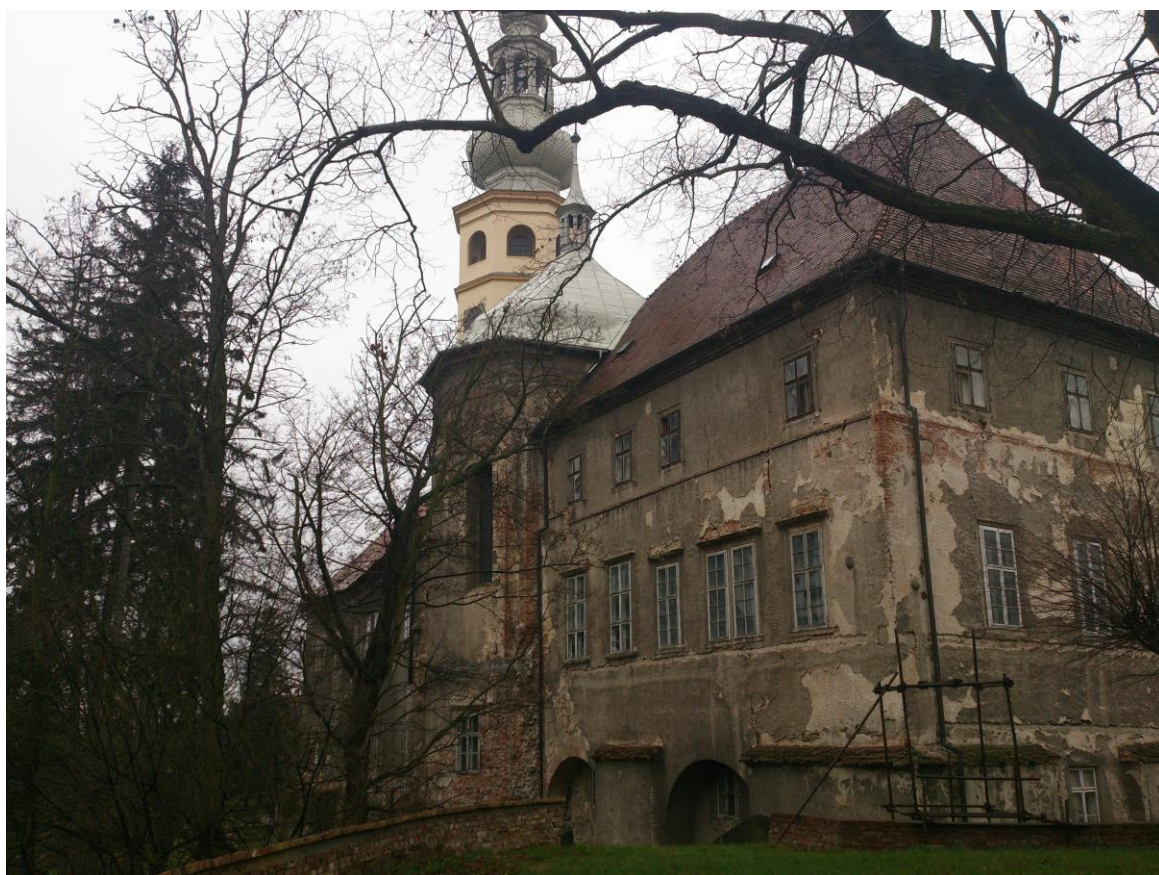
52. Fasáda východního, severního křídla s kaplí uprostřed.
