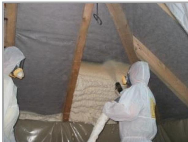
Obr. 1.4 – Nástřik PUR pěny v podkroví [10]
