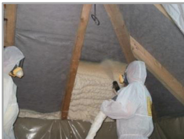
Obr. 1.4 – Nástřik PUR pěny v podkroví [10]
