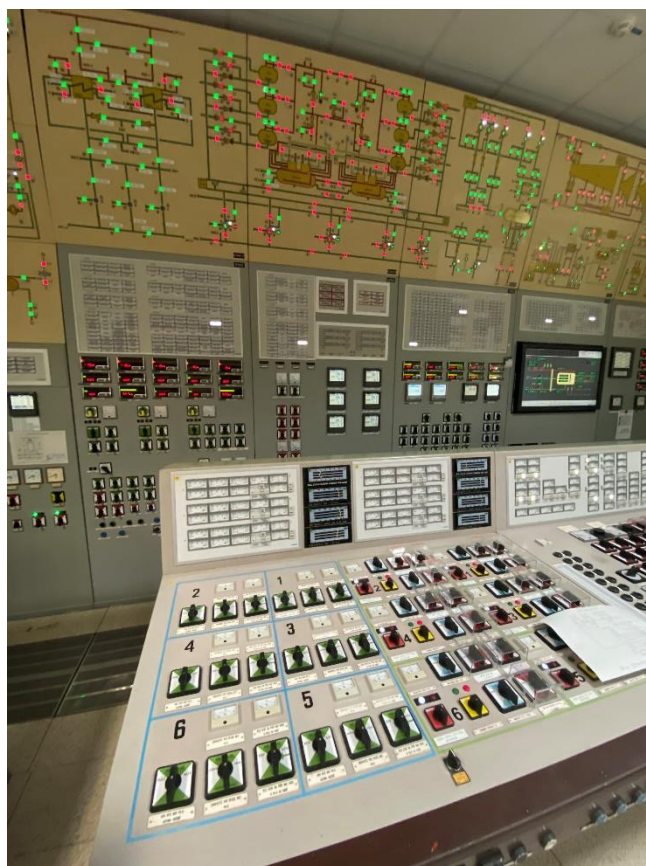
Obr. 4: Blokova dozorna [vlastní zdroj]
