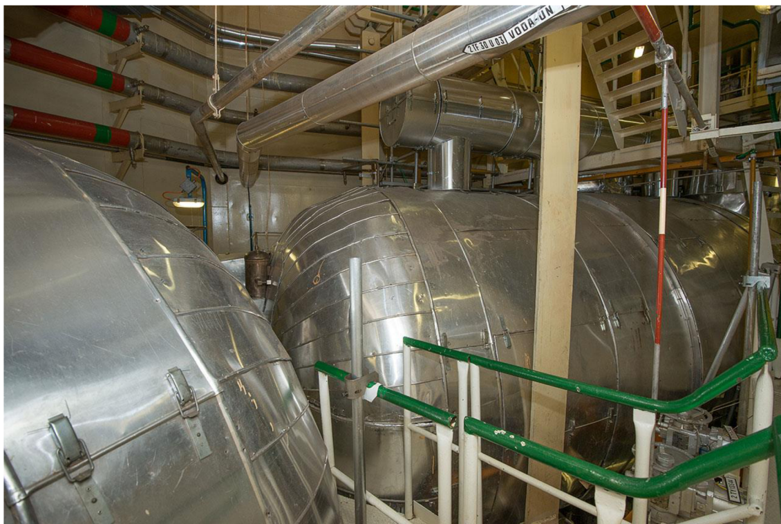
Obr. 9: Tlaková nádoba PG VVER-440 [7]
