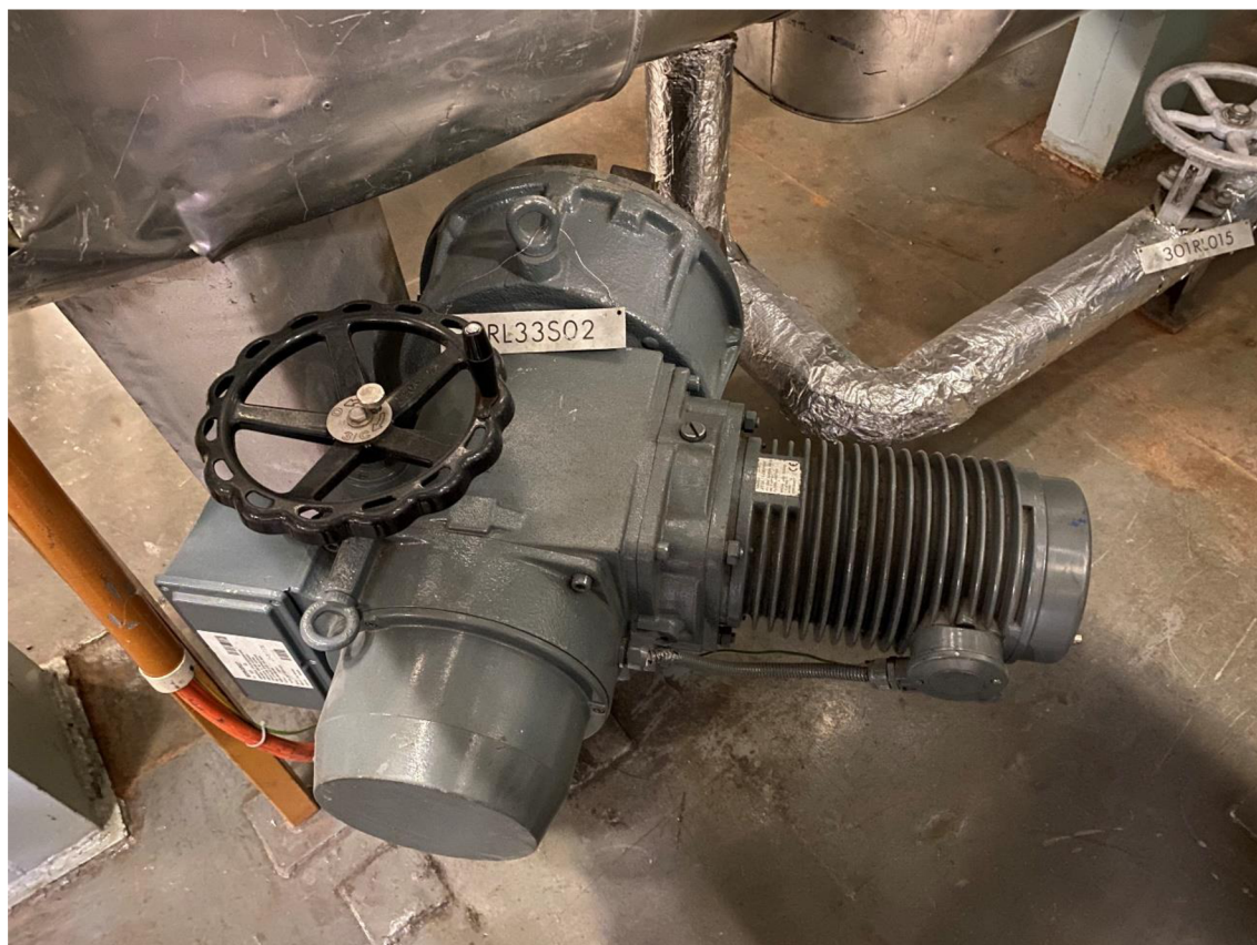
Obr. 11: Regulační armatura 3RL33S02 [vlastní zdroj]
