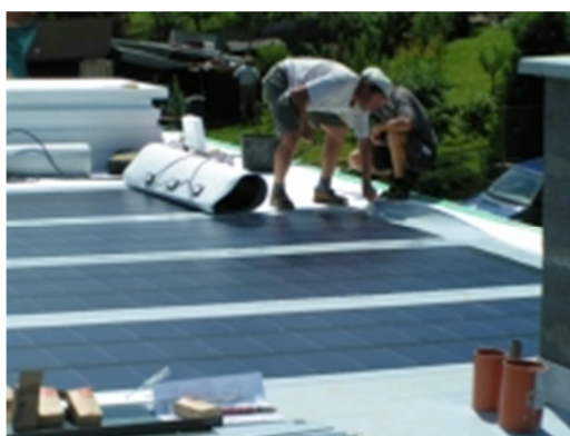
Obr. A-21 : Instalace fotovoltaické fólie [22]
