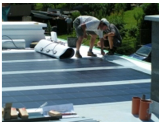
Obr. A-21 : Instalace fotovoltaické fólie [22]
