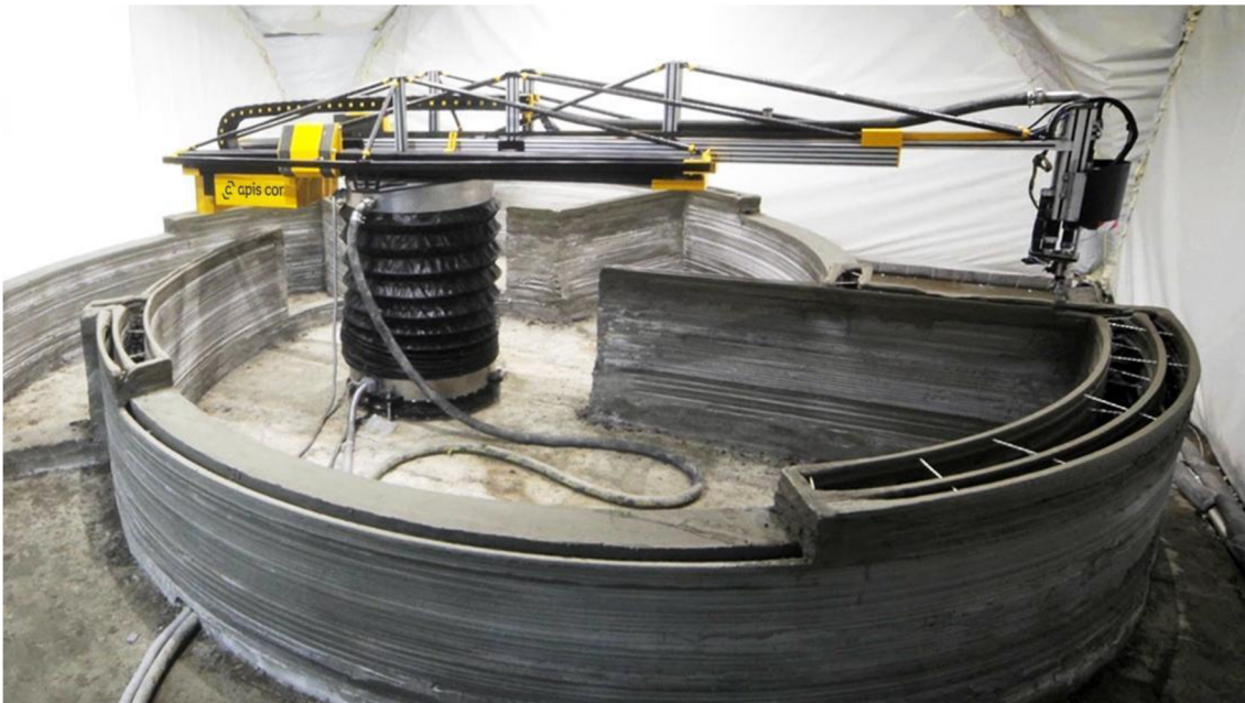
Obr. 1 Průběh tisku domu pomocí jednoramenné 3D tiskárny [10].
