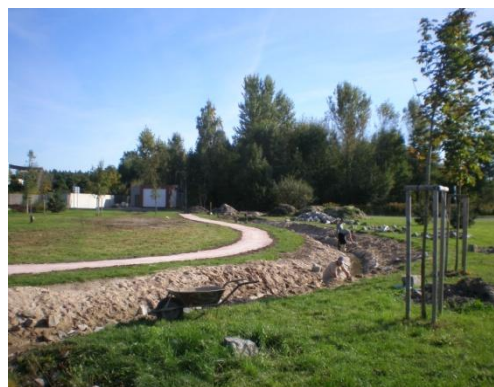
Obr. 10 - Probíhající výstavba vodoteče
