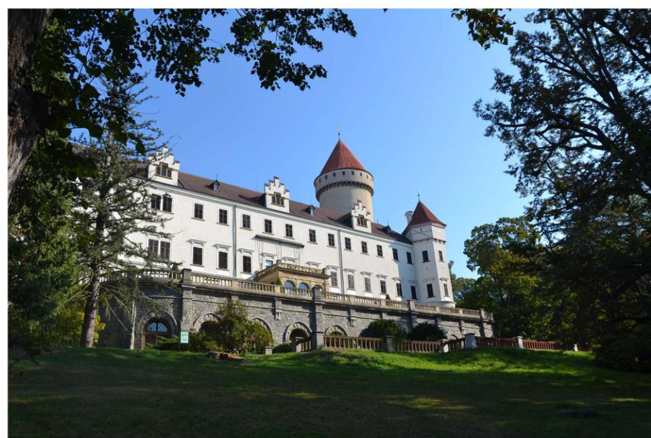
Obr. č. 34: Pohled na zámek Zdroj: Vlastní foto
