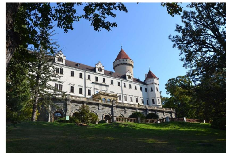
Obr. č. 16 – Pohled na zámek. Zdroj: Vlastní foto
